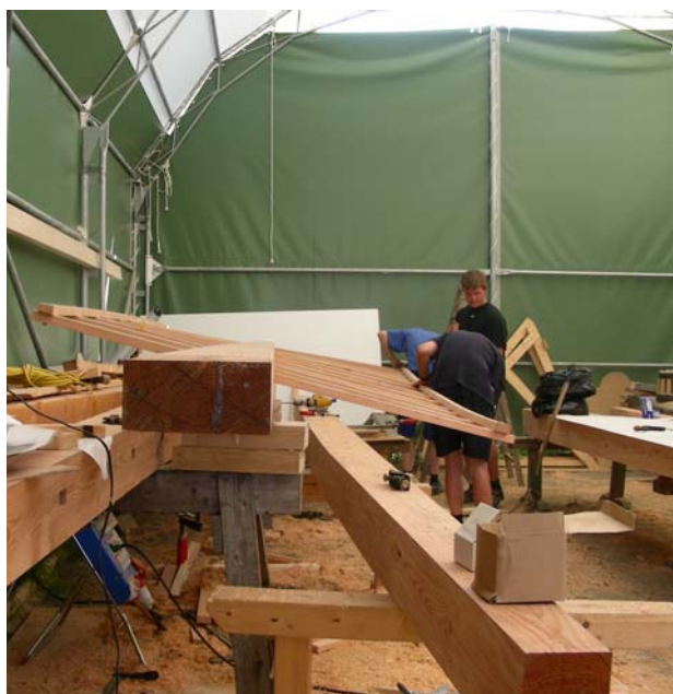
Den første vinge er samlet med de gennemstukne ”hækskeder” og ”rielægter”.
