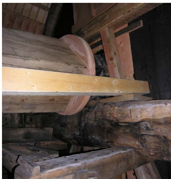
Tømmeret hviler af på vindbjørne i gavlen.
