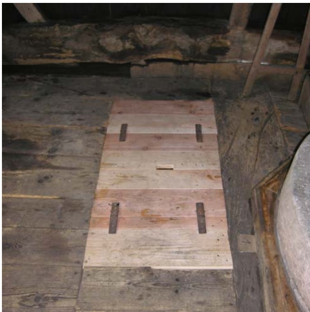
Lemmen i kværnloftgulvet måtte udskiftes.
