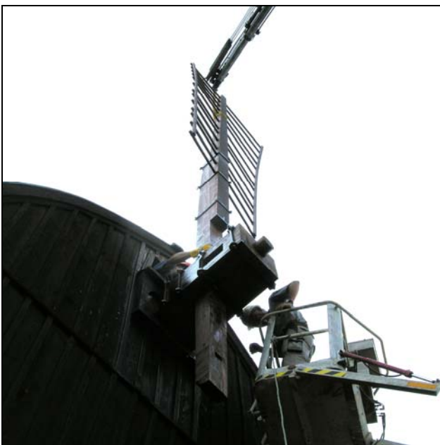
Første vinge med kolle sættes på – stikkes igennem "åshovedet"
