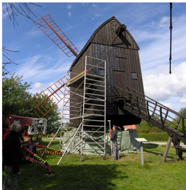
Tjæring fra stillads og lift.
