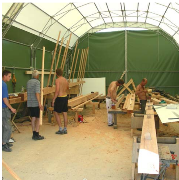
Der arbejdes på de to sæt vinger – til venstre ”splitsejlvingerne” til Bechs mølle. Juni 2006.
