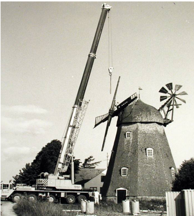
1994. Hatten er løftet på plads og vingerne er ved at blive monteret af firmaet Poul Larsen store gule kran.
